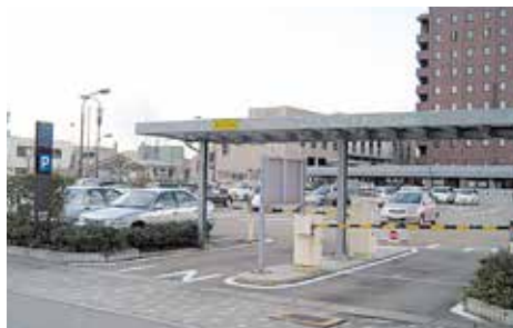
砺波駅南口ちゅう車場
