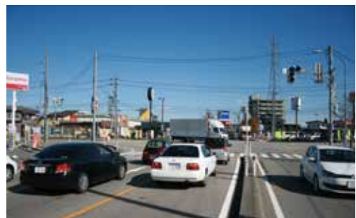
砺波インターチェンジ近く
