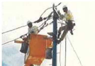
ふっきゅうさぎょう 電気会社による復旧作業
