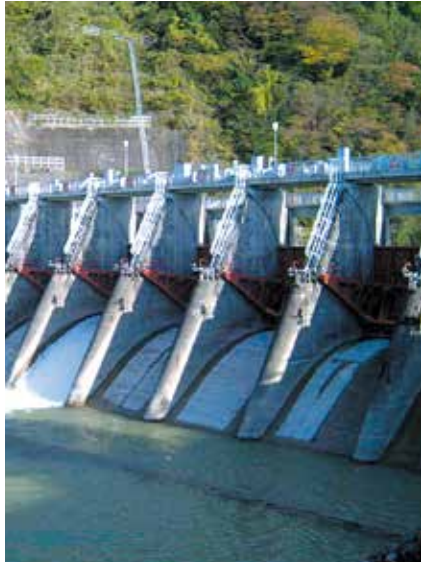
合口ダム (砺波市庄川町金屋)
