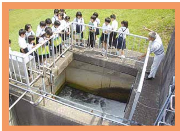
合口ダムから浄水場に水が送られてきたところ
