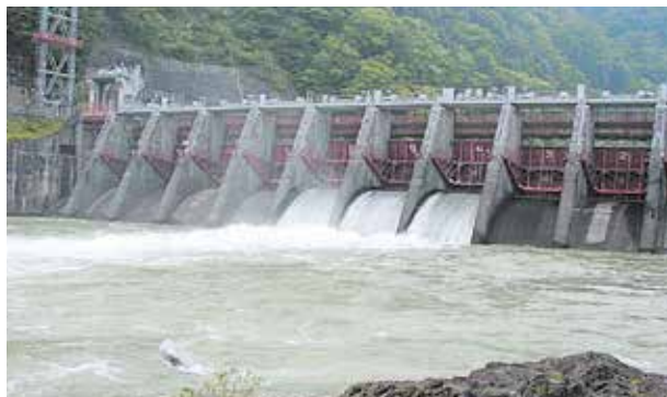
合口ダム(砺波市庄川町金屋)
